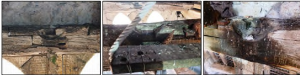
De gauche à droite, les photos des anciens emplacements de paliers, marqués de 1 à 3 sur le schéma.
