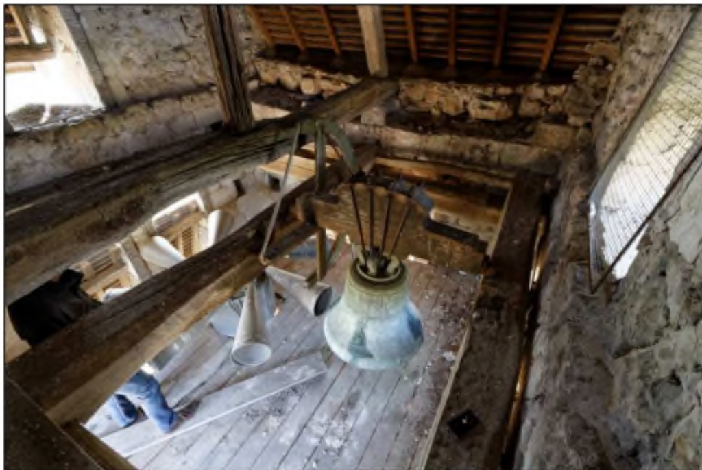
Vue du dessus de la chambre des cloches.
